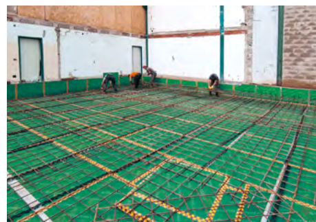
Office building foundation, Romano d'Ezzelino, Vicenza.
